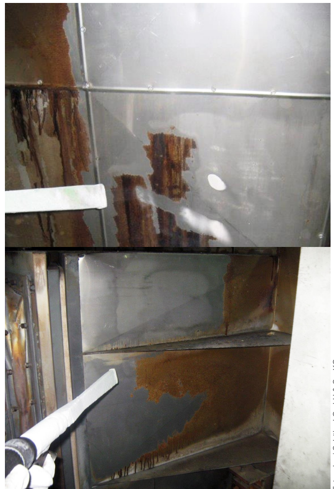
Ergebnisse des Trockeneisstrahlens vor Ort
