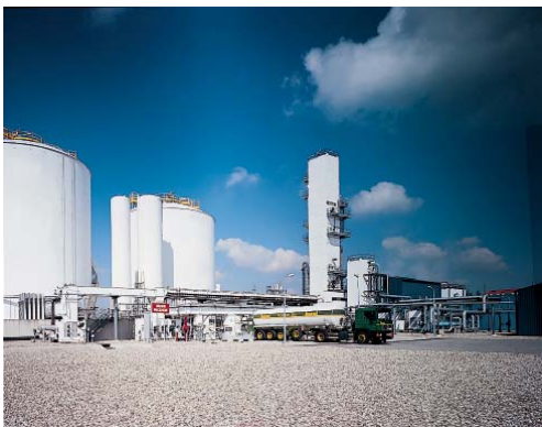
Produktionswerk für Luftgase, Straßburg
