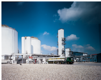
Produktionswerk für Luftgase, Straßburg
